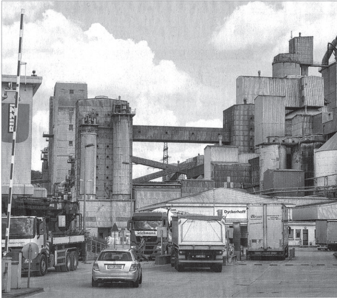
Dyckerhoff in Lengerich will weiter direkt vor Ort Kalk abbauen.
